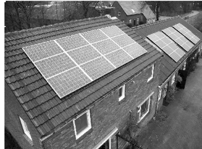
De zonnepanelen op huis en schuur
